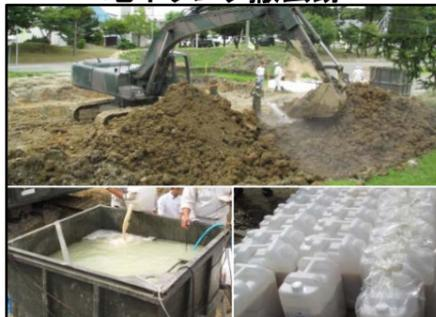
陸上自衛隊の地下タンク撤去時におけるタンク周辺の油分浄化
