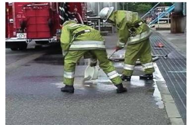
3. 防火製剤を漏洩油に散布し、吸収させる。
